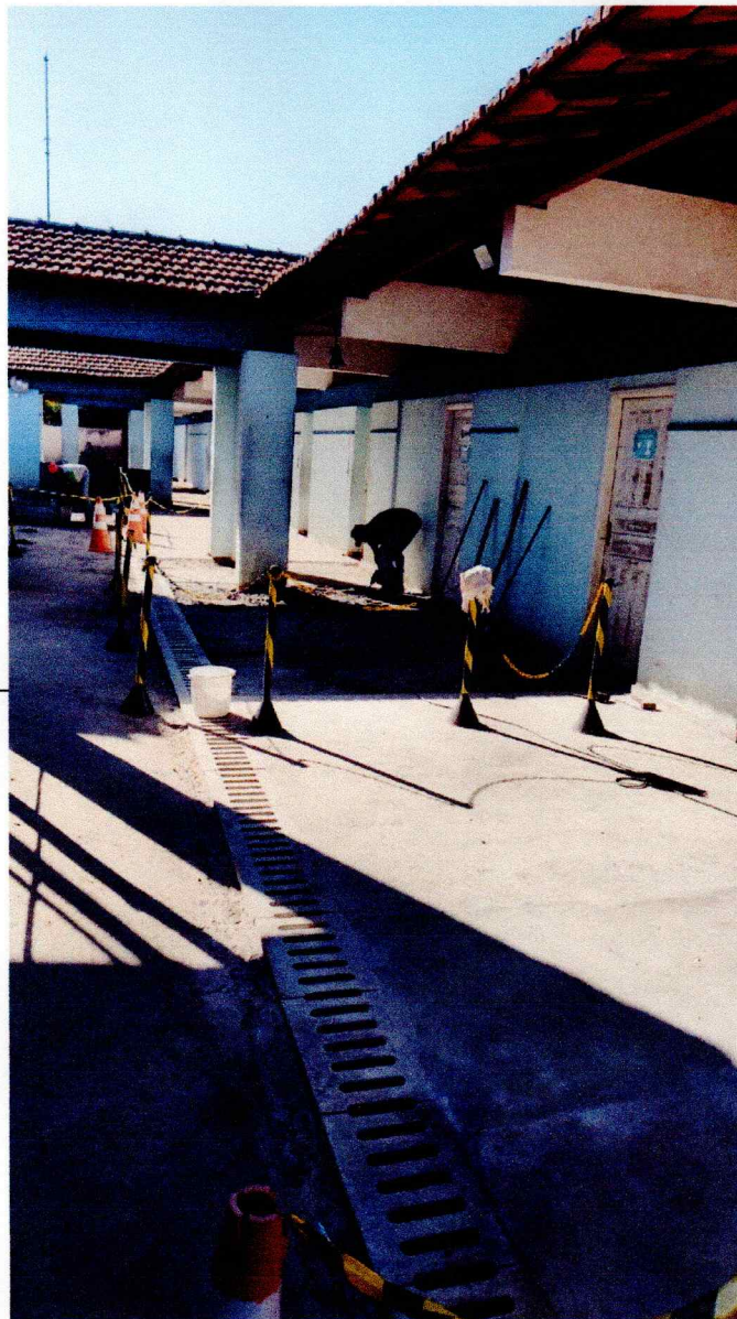
CONCRETAGEM DO PÁTIO E EXECUÇÃO DA GRELHA.
