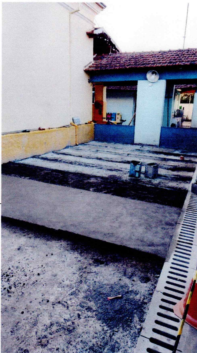
CONCRETAGEM DO PÁTIO E EXECUÇÃO DA GRELHA.
