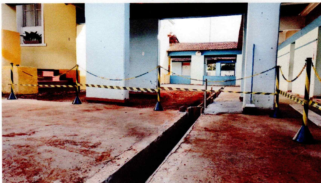
CONCRETAGEM DO PÁTIO E EXECUÇÃO DA GRELHA.
